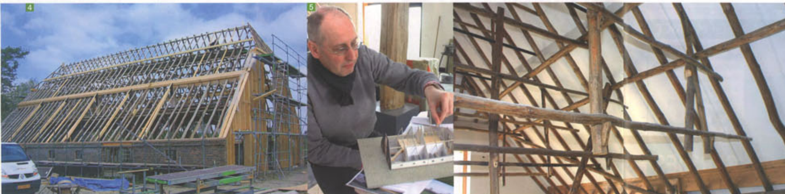
4. In de dakconstructie worden de nodige verstevigingen aangebracht, die uiteindelijk niet of nauwelijks meer zichtbaar zullen zijn. 5. Als rechtgeaard bouwkundige maakt Arnold uiteraard een fraaie maquette van de boerderij. 6. De authentieke houtconstructie moest koste wat het kost zichtbaar blijven. In plaats van pen-gateverbindingen zijn vaak schroefverbindingen toegepast, die een zwarte verflaag kregen.
